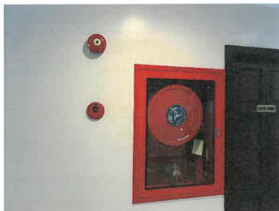
รูปที่ 3.2-34 ตู้เก็บอุปกรณ์ดับเพลิง (FHC)
