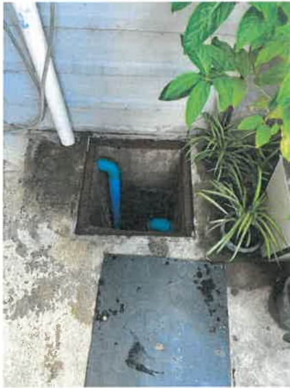
รูปที่ 3.2-6 ท่อระบายน้ำและบ่อหน่วงน้ำของโครงการ
